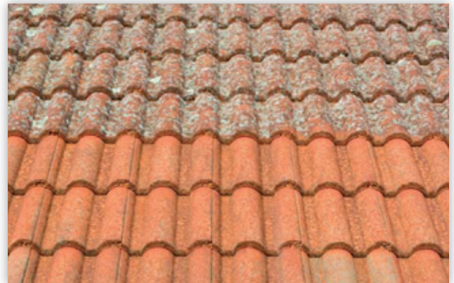
teilweise behandeltes Dach
